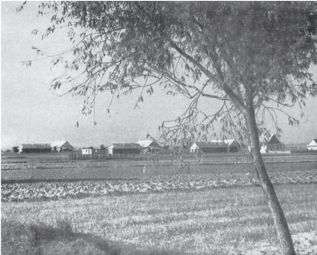
Ilustracja 11. Piaseczno, widok w czasie budowy, fot. Lutyk, 1947. Wg: S. Tworkowski, Architektoniczny rezultat Piaseczna , „Architektura”, 1947, z. 2, s. 44
